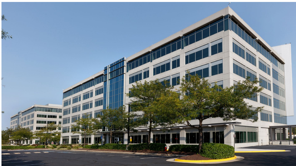
取得したオフィスビル 外観
